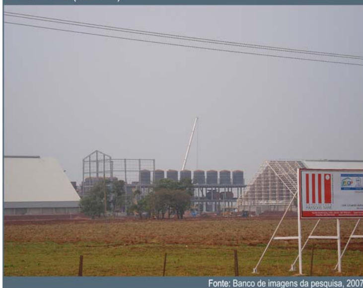
Figura 25. Construção da usina Coinbra Cresciumal, no município de Rio Brilhante/MS. (20/09/07)
